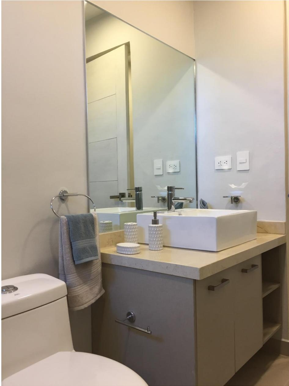
Baños. Mueble de baño con meseta de mármol para lavabo y gabinetes de carpintería en color claro y espejo de 3mm de espesor adherido a pared.
